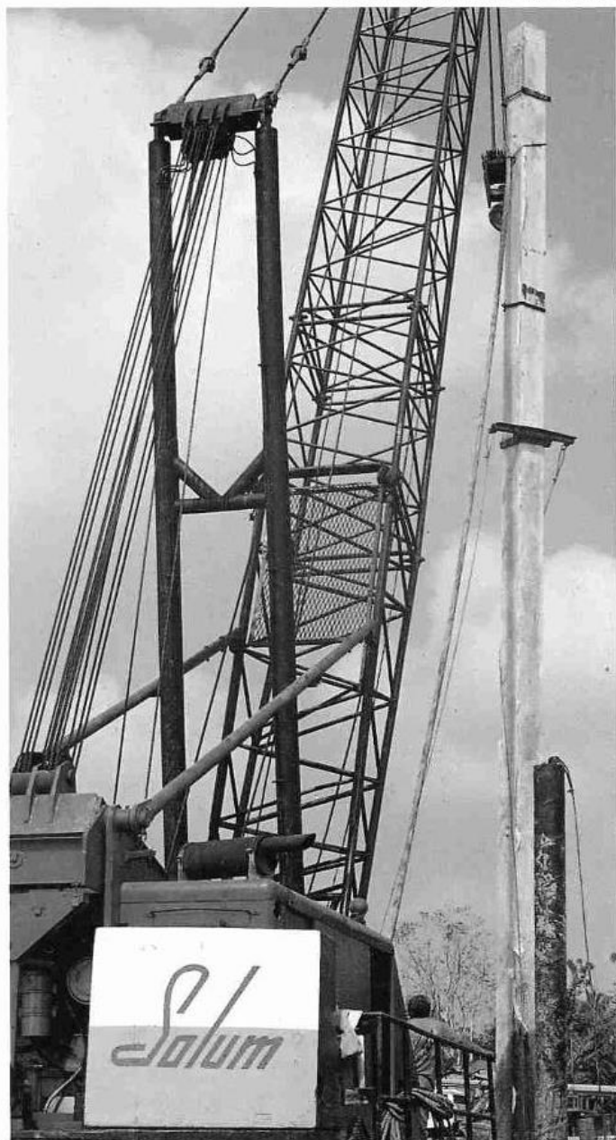
Aspecto del hincado de pilotes.
