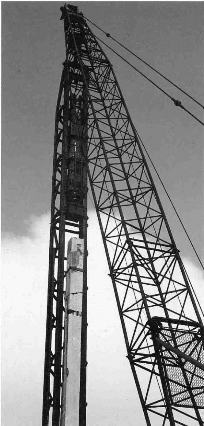
Colocación del martillo piloteador.
