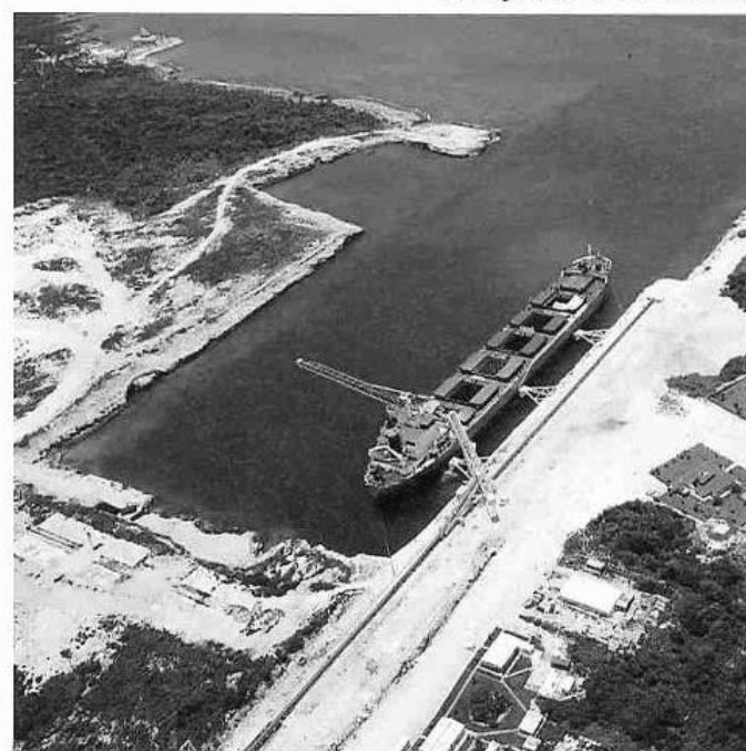
Vista general de la dársena.
